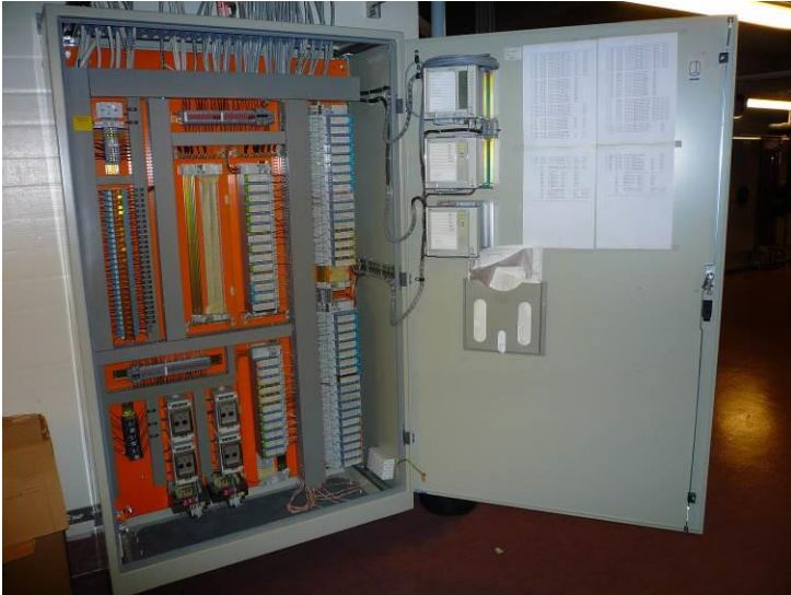
Kuva 4. Moduulirakenteinen alakeskus.
