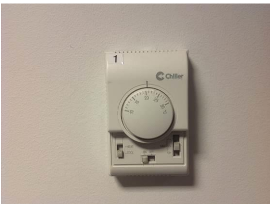
Kuva 5. Yksikkösäädin.
