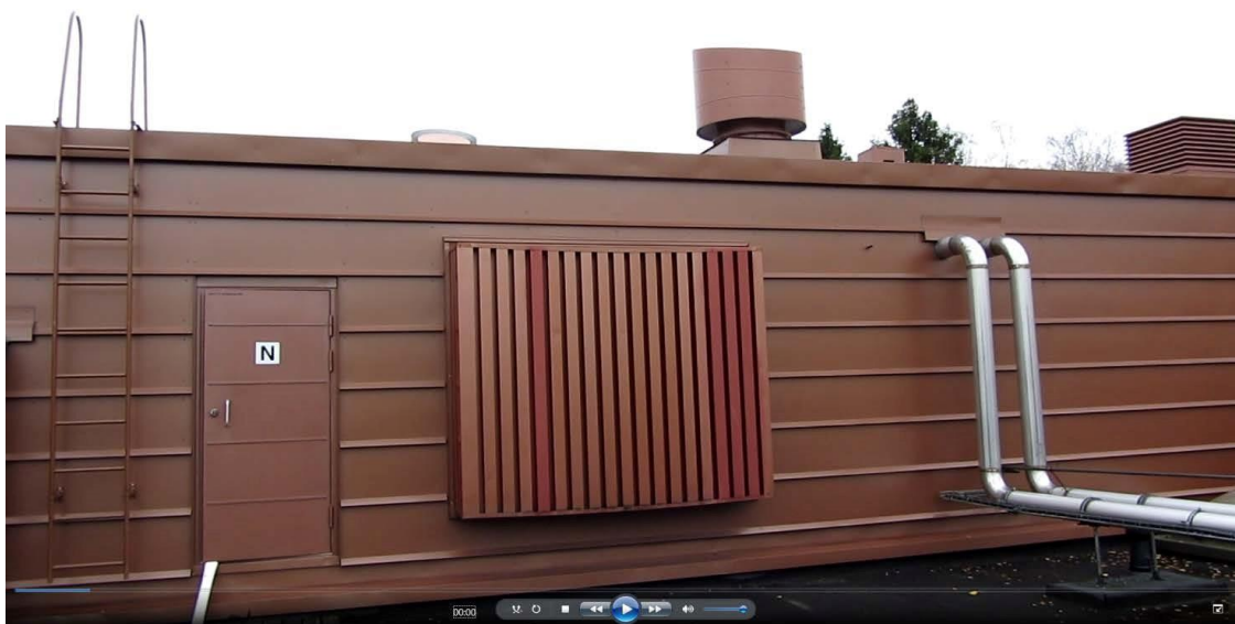
Kuva 2. Ulkoilman sisäänoton ja jäteilman ulospuhalluslaitteen sijoittuminen toisiinsa nähden tulee tarkastaa. Sijoittelussa tulee varmistua siitä, ettei sisään otettavaan ulkoilmaan pääse sekoittumaan ulospuhallettua jäteilmaa. Sisäännotosta tulee tarkastaa myös muu ilman kulkeutumisen esteettömyys, esimerkiksi lumen keräytyminen läheisille pinnoille tulee huomioida.
