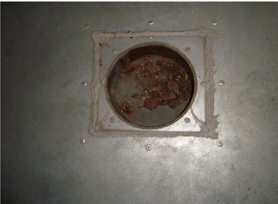
Kuva 6. Konehuoneiden ja kammioiden kaivojen puhtaus tarkastetaan.
