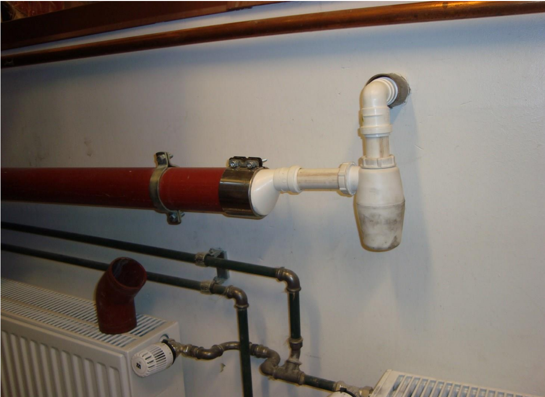
Kuva 7. Ulkoilmakammioiden liitokset viemäriin tarkastetaan. Varmistetaan, ettei asennuksissa ole peräkkäisiä vesilukkoja. Lisäksi on syytä varmistaa, ettei viemäri pääse tuulettumaan ulkoilmakammioon vesilukon mahdollisesti kuivuessa ja aiheuttamaan hajuhaittoja.
