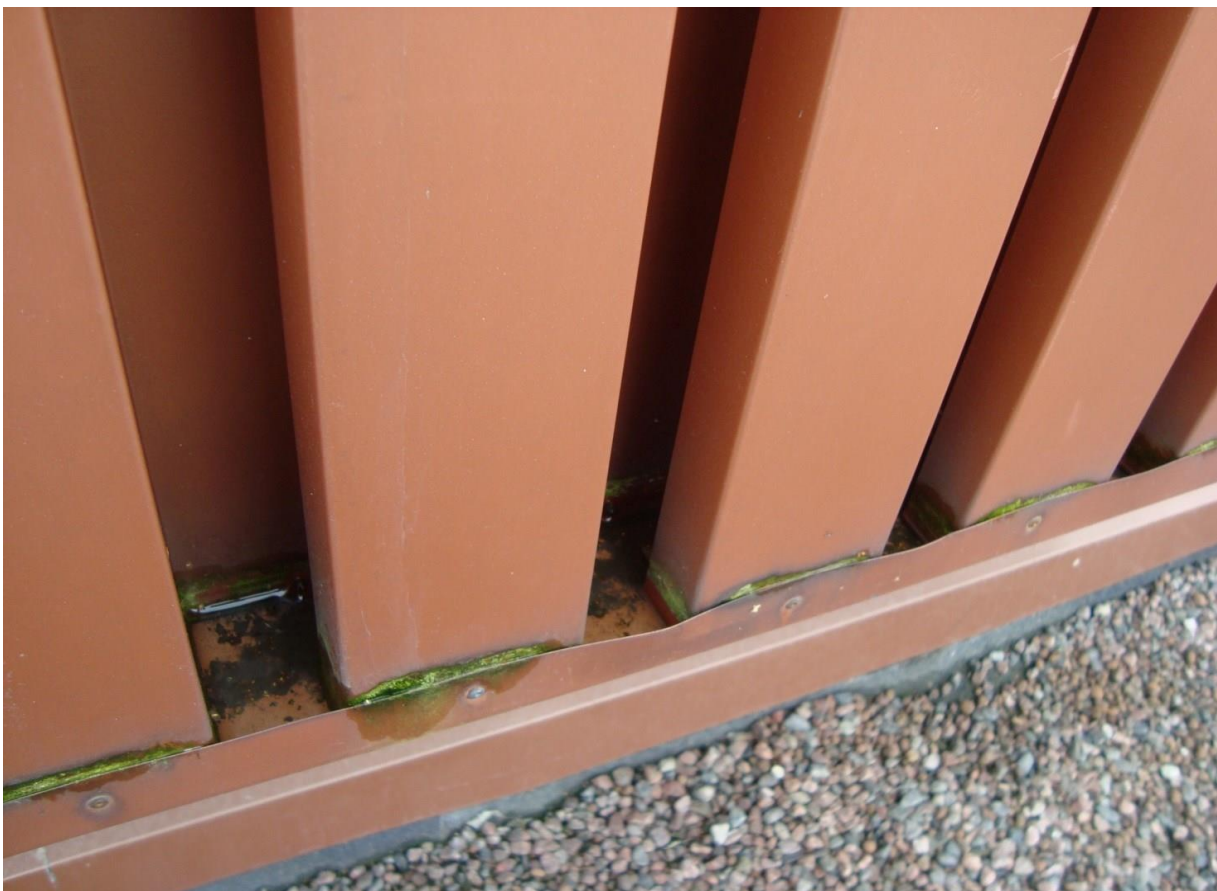
Kuva 4. Ulkoilman sisäänottosäleikön vedenkeruun ja -poiston toiminta on tarkastettava.
