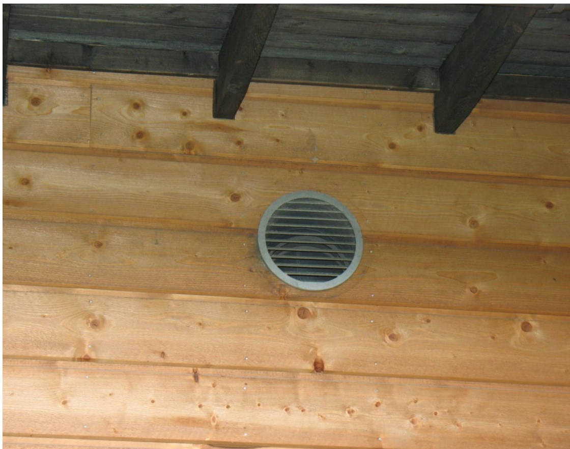
Kuva 1. Koneellisen ilmanvaihdon ulkoilman sisäänoton säleikön puhtaus ja muu ilman kulkeutumisen esteettömyys tulee tarkastaa. Tähän sisältyen tarkastetaan, ettei hyttysverkkoja ole.
