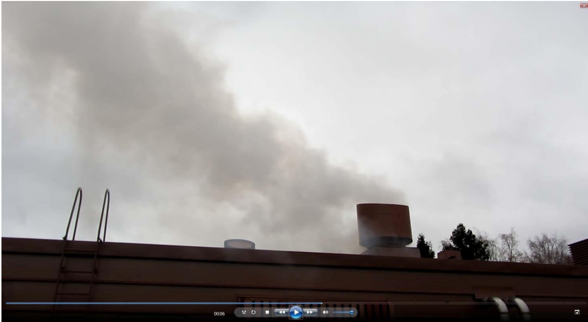
Kuva 3. Jäteilman ulospuhalluslaitteen toimivuus voidaan tarkastaa merkkisavun avulla.
