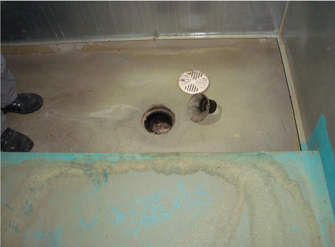
Kuva 5. Konehuoneiden ja kammioiden kaivotyyppit ja mahdollinen viemärointi selvitetään. Haju- jujen leviämisen kannalta riskialttiit ratkaisut pyritään paikallistamaan.
